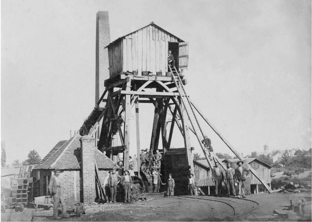
Travaux sur le puits des Zagots, vers 1875-1880.
