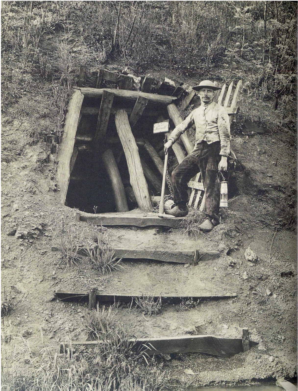
Mineur de Montchanin. Ce type de descenderie était semblable à La Machine vers 1880-1890.
